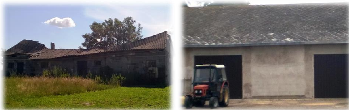
Rysunek 1. Wyroby azbestowo-cementowe: po lewej płyty faliste, po prawej płyty płaskie (źródło: materiały własne).
